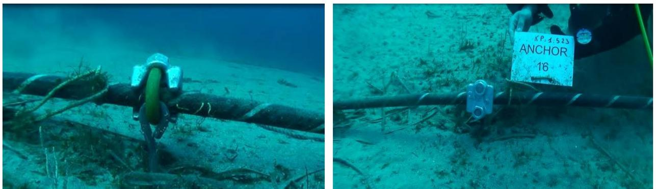
Figure 10 : Autre système de fixation du câble à l'ancre retenu pour le projet (Orange Marine)
